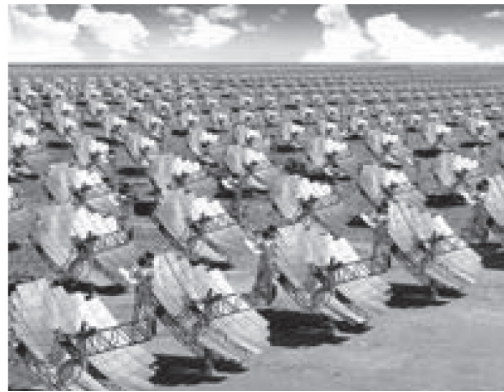
شکل ۲۲: متمرکز کننده های خورشیدی در یک نیروگاه خورشیدی
